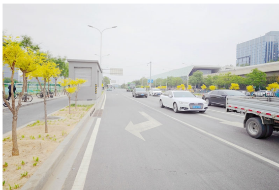
项目东侧现状道路
